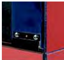
OFFENE ECKFUGE MIT EPDM BAND Bild 2
