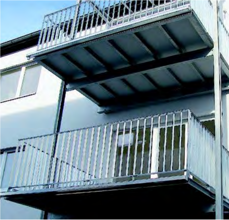
BALKONBODENPLATTE OBJEKT ST. VEIT/GLAN, ÖSTERREICH
